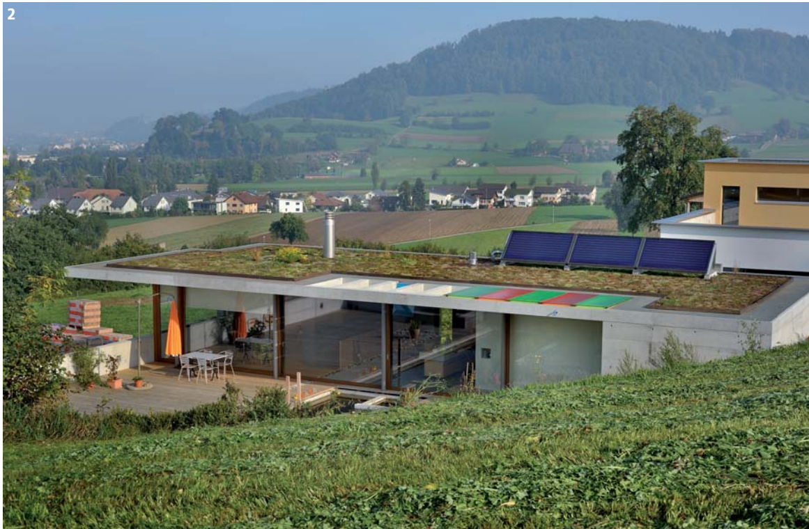
Foto gross) Eingangsbereich und Zufahrt sind geschützt vor Wind und Wetter. 1) Das betonierte Wohngeschoss ruht auf einem zurückversetzten dunklen Sockel. 2) Mit dem begrünten Flachdach ist das Gebäude ins gewachsene Terrain integriert.
